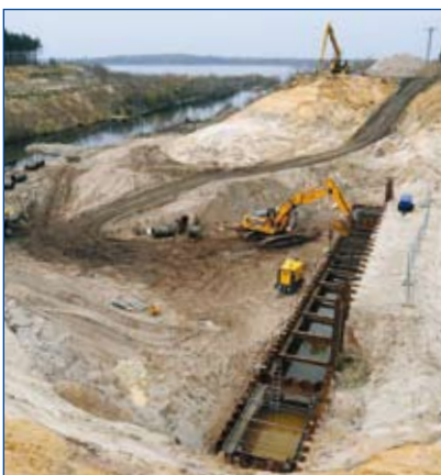
Bau des Kanals auf der Seite des Partwitzer Sees
