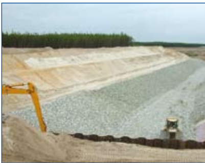
Bau des Kanals auf der Seite des Neuwieser Sees
